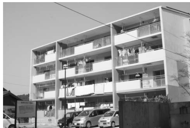
町営住宅（谷下団地）
